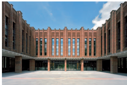
Seit September 2009 hat AmpegaGerling seinen Hauptsitz in der Kölner Rheinpark Metropole, dem größten Bürogebäude Deutschlands.
